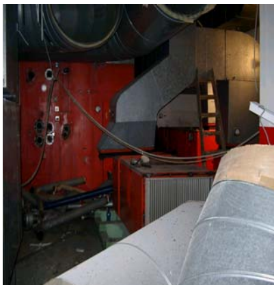
Abbildung 4.1: Rückbau der Klimazentrale im 10. OG.
