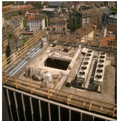
Abbildung 4.2: Aufgefräste Betondecke für Abtransport der grossen Bauteile aus dem Gebäude.
