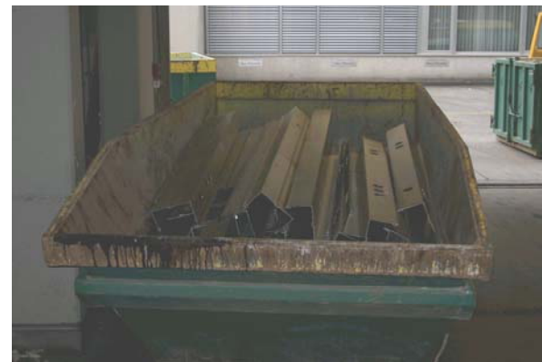
Abbildung 3.4: In Mulden gesammelte Brüstungskanäle aus Aluminium.
