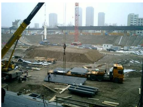
Bauverlauf V (Februar 2007)
