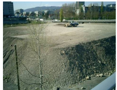
Depot Geerenweg (April 2007)
