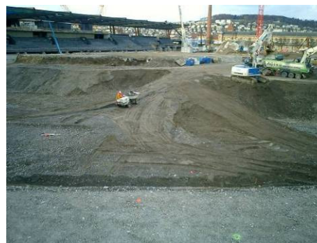
Bauverlauf II (November 2006)
