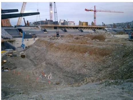
Bauverlauf I (Oktober 2006)
