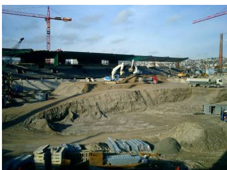
Bauverlauf III (Dezember 2006)
