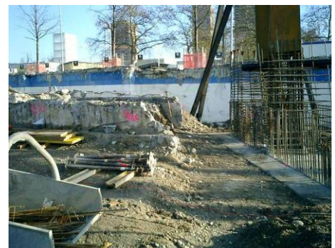
Neubau und Rückbau dicht beieinander (Dezember 2006)
