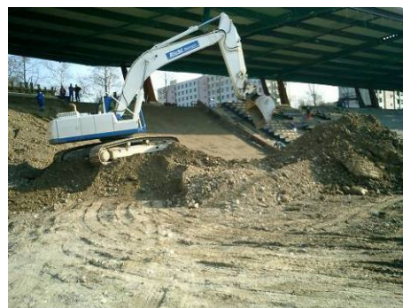
Bauverlauf VI (März 2007)
