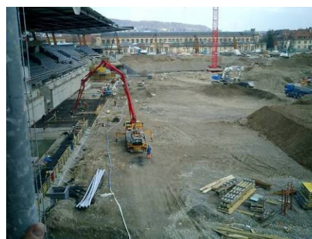
Bauverlauf IV (Januar 2007)
