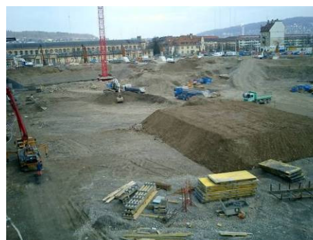
Zwischenlager von Aushub (Januar 2007)
