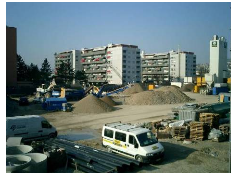
Aufbereitung von Kies und Betonproduktion vor Ort (März 2007)
