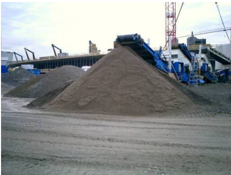
Aufbereitung von Kies (Oktober 2006)
